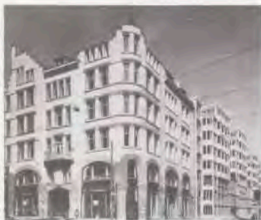
Afb. 3. Oud en nieuw in Amsterdam. Het Witte Huis (1901) en de nieuwbouw (1984) vormen samen het P.C. Hoofthuis (hoek Raadhuisstraat/Spuistraat) van de Faculteit der Letteren van de Universiteit van Amsterdam. Uit: I. Haagsma en H. de Haan, Stadsvernieuwingsgids van Amsterdam (Amsterdam 1985) 31.
