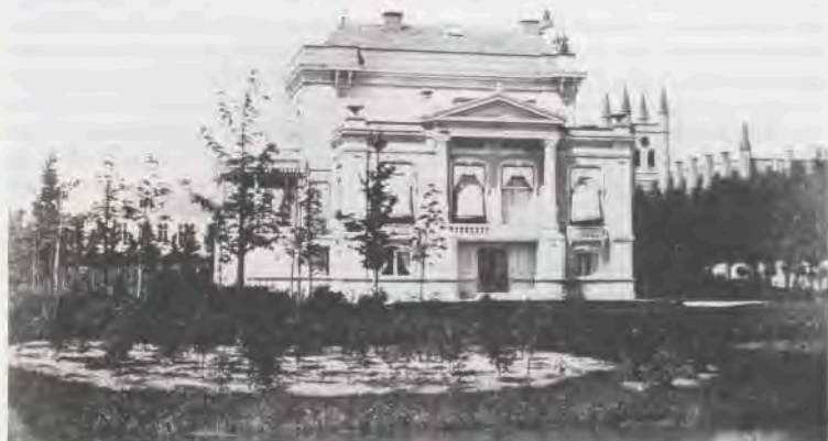
Afb. 1. Een villa aan de Nassaulaan uit 1861 (afgebroken omstreeks 1915). Foto Gemeentearchief 's-Gravenhage.
