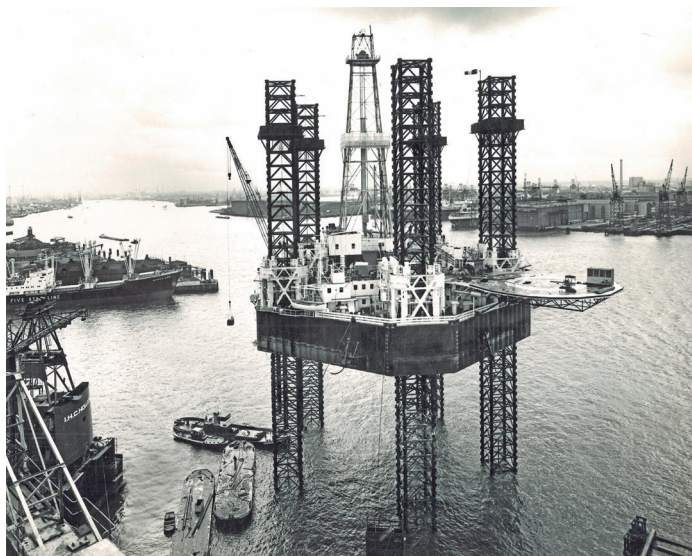
Afb. 1 De werf Gusto in Schiedam richtte zich al in de tweede helft van de jaren zestig op de offshore-industrie. Het vijfpalige booreiland Sedneth II werd in 1968 gebouwd. Maritiem Museum Rotterdam, inv.nr. FS3416.
