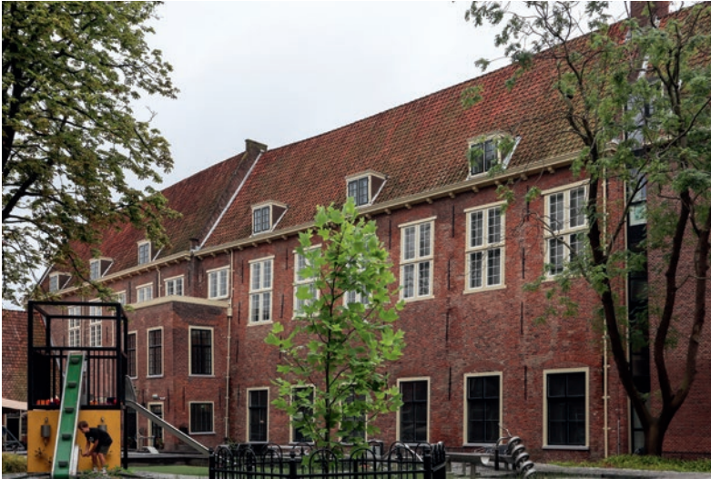
Afb. 6 Zicht op de noordzijde van het voormalige pest- en dolhuis. De grote ramen op de eerste verdieping behoorden tot de pestzalen. Het complex is verschillende keren gerenoveerd en gerestaureerd (de ramen op de begaande grond zijn dan ook niet origineel). Foto: Mats Dijkdrent, 2022.
