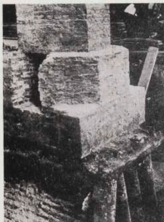
Afb. 18 Kerk: Een kolom uit de vijftiende eeuw, die rust op de noordwesthoek van het dertiende eeuwse schip.
