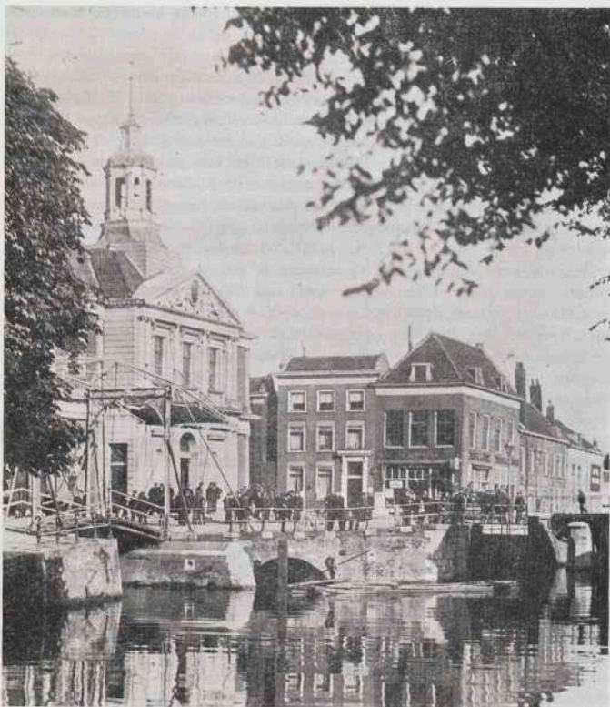
Afb. 7 De Dam ter plaatse van de nieuwe sluis, in het midden het Keizerrijk, het pand links is het hoofdhuis, rechts de zijkamer.
