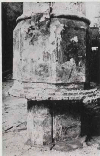
Afb. 22 Kerk: de na 1428 verzwaaide kolom tussen het midden- en noordkoor.
