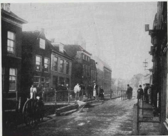
Afb. 14 De Langekerkstraat aan het einde van de negentiende eeuw naar het westen gezien. Het tweede steegje links is de Baansloot, overblijfsel van de oudste stadsgracht; het ervoor staande huis met gepleisterde gevel is ten dele in deze oude gracht scheefgezakt.
